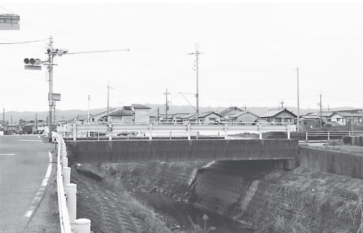
補修を予定する三代川橋
