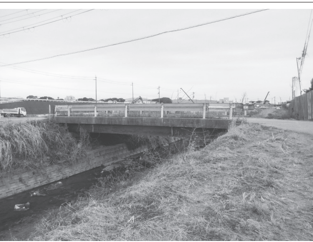
南側(手前)に架け替えられる下磯田上橋
