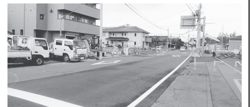
電線共同溝工事を予定する「畝傍駅前通り線」
