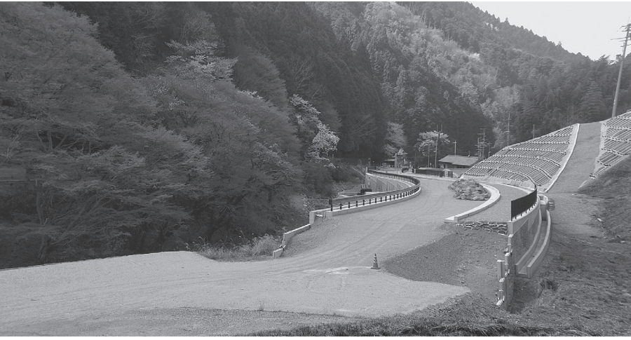
来春の供用を目指す「百市工区」バイパス区間
