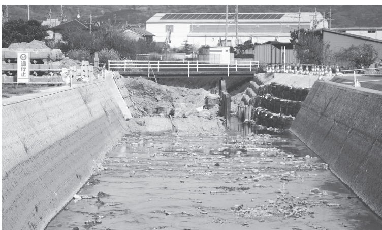
大久保井堰の工事を行っている「地蔵院川」
