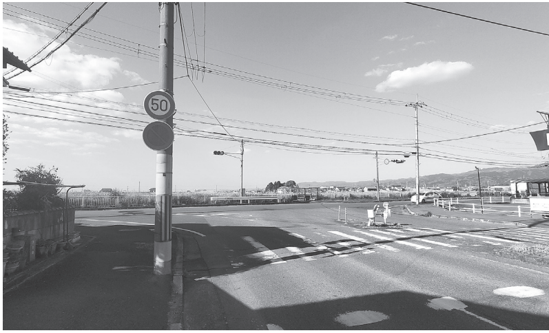
「九条バイパス」が接続を予定する天理橋線北端
