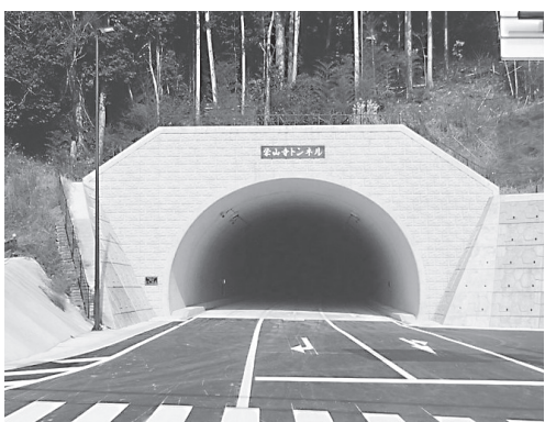
トンネル坑口(南側)
