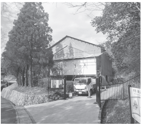
工事を行っている「旧八重川家住宅」
