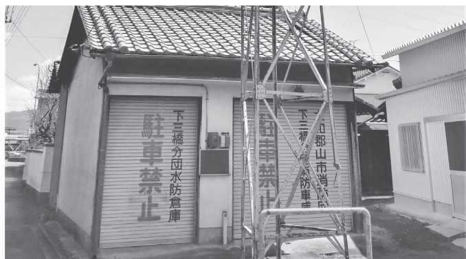
狭隘な道路に面した既存の消防倉庫
