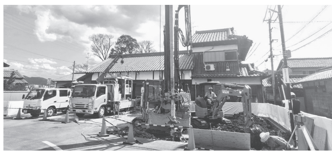
地盤改良作業進む
