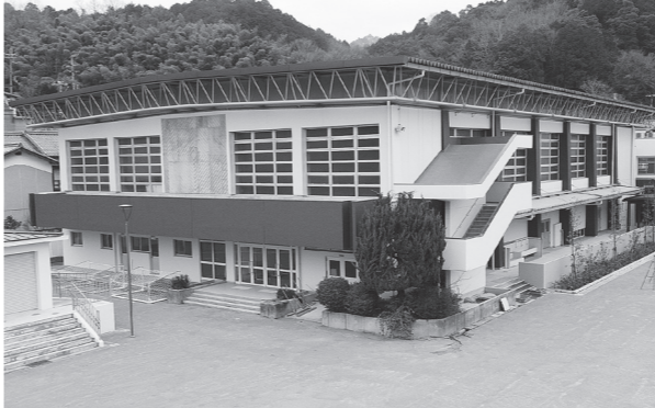
改修工事を行った屋内運動場
