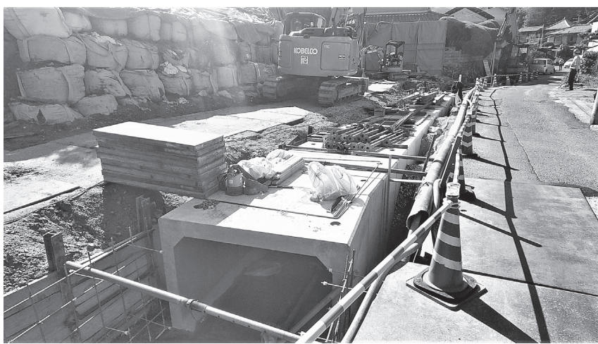
カルバートを設置
