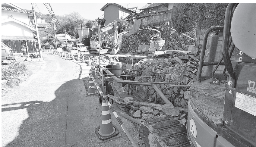
水路更新と道路の拡幅を行う
