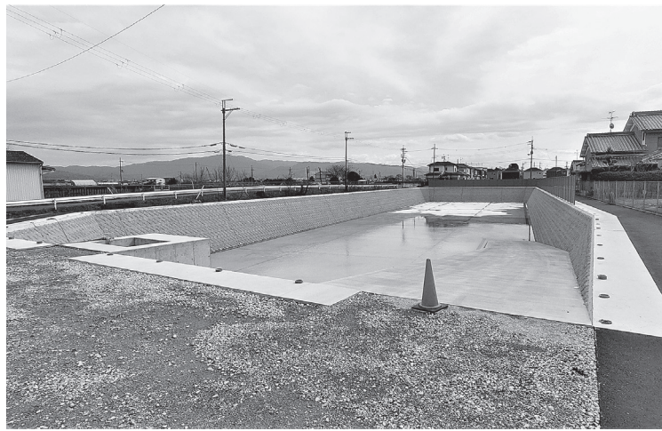
旧県水資材置場雨水貯留施設
