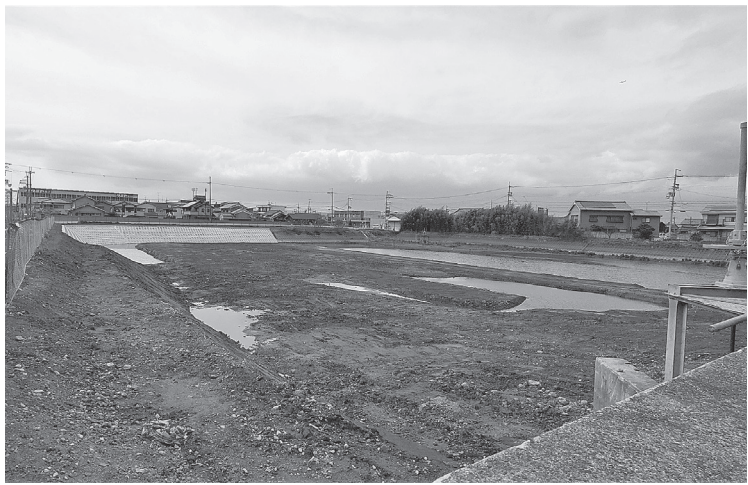
隣接する「阪手新池」も貯留施設として整備する
