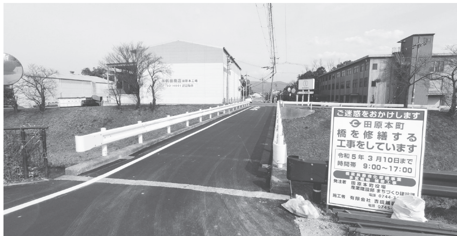
補修工事を終えた「多宮橋」
