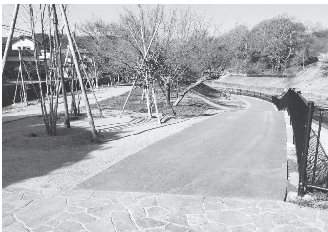
柵や舗装など設備を更新
