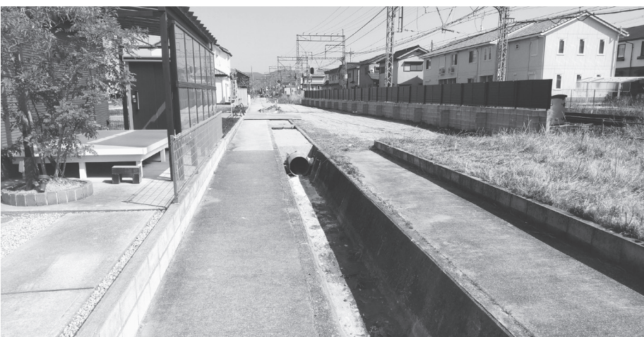
用水路を暗渠化し管理用通路として整備する
