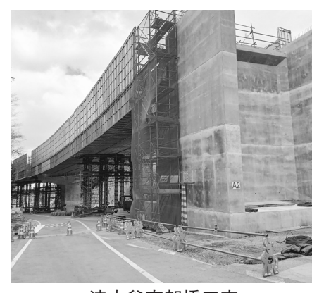
清水谷高架橋工事 事業区間 高取町兵庫～高取町清水谷 延長・幅員 L=3400m W=8.5m (暫定2車線)
