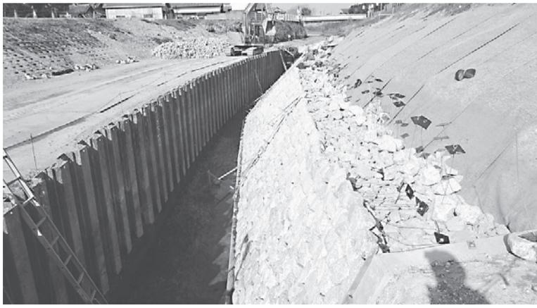
・工事延長L1141m、アンカー式空石積工A11512
