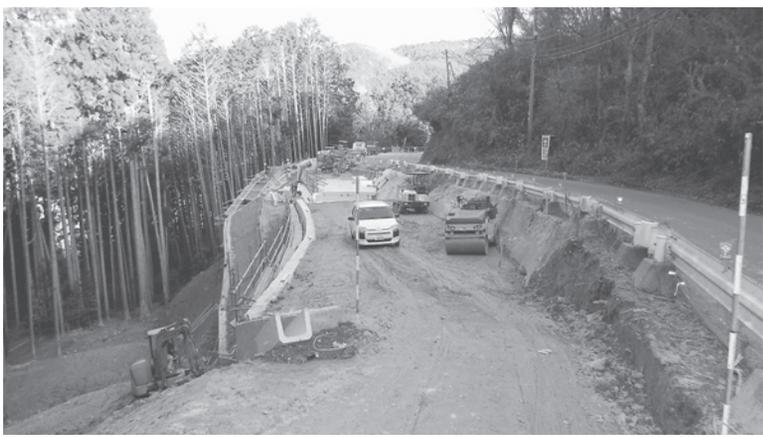
・工事延長L1190m、補強土壁工A11250m、軽量盛土工V11630m
