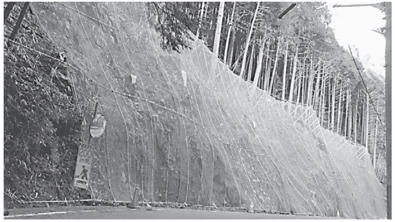
・工事延長L1141m、ポケット式落石防護網A112390m
