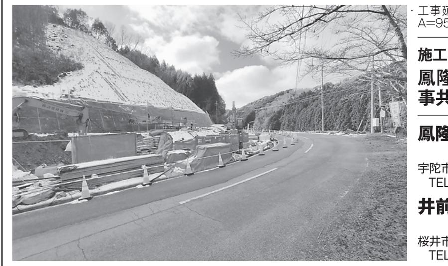
工事延長L=280m、補強土壁工A=951㎡、鉄筋挿入工N=239本
