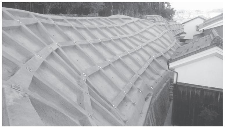
・工事延長L1145m、吹付砕工L11592m、鉄筋挿入工N11242本
