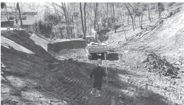
・工事延長L113.2m、コンクリート堰堤工(透過型)N111基
