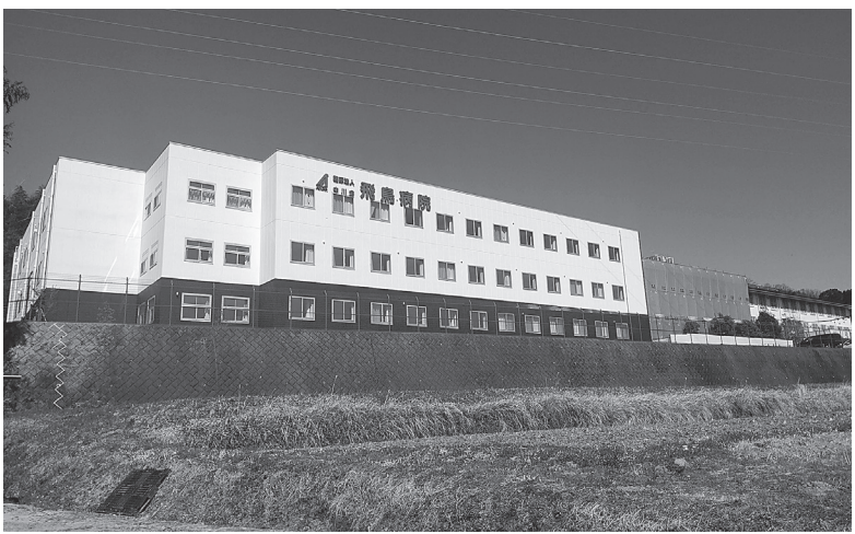
完成した南館新病棟
