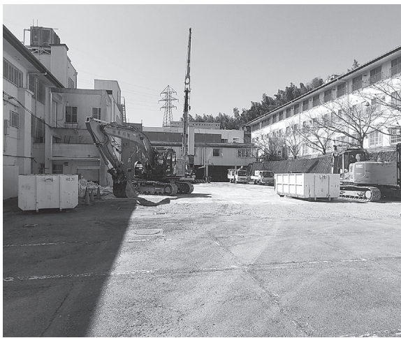
旧南本館を部分解体する
