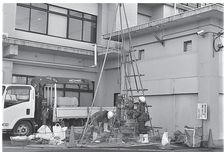
庁舎南東側で行われたボーリング調査
