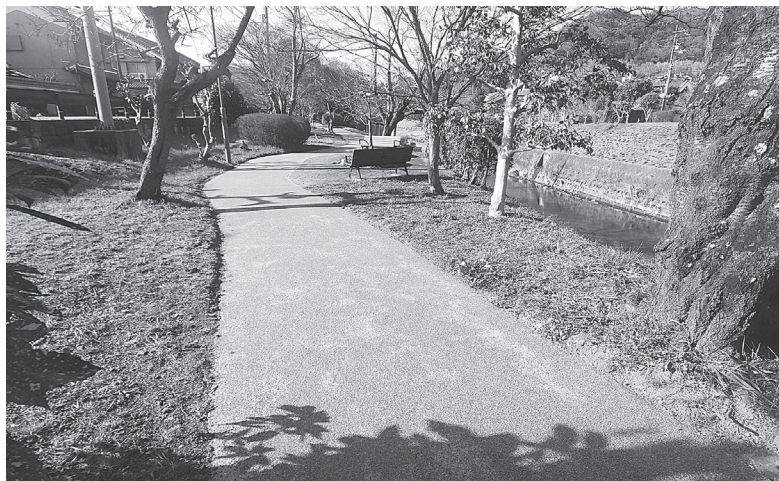
園路の滑り止め舗装を更新
