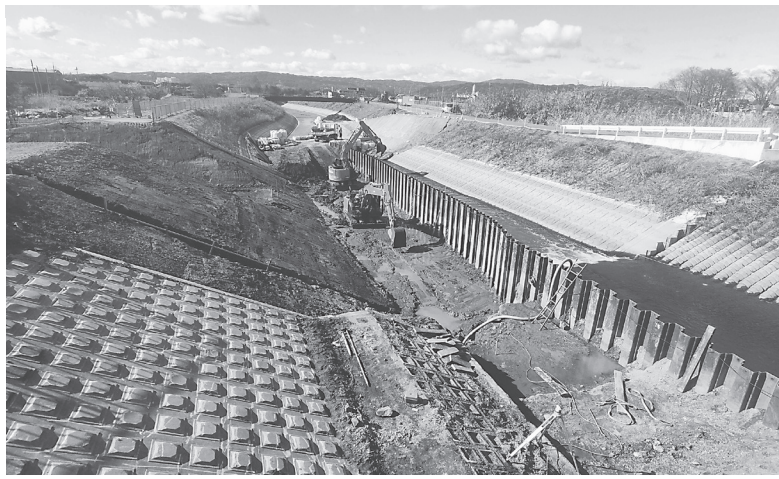
河床を掘き基礎打設を行う
