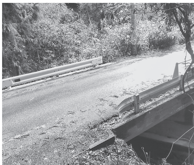
工事を終えた「滝橋」
