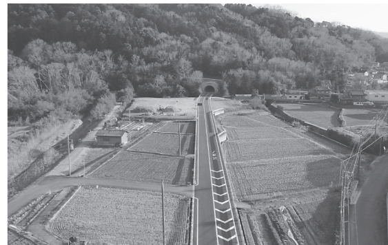
北側より柴山寺トンネル臨む
