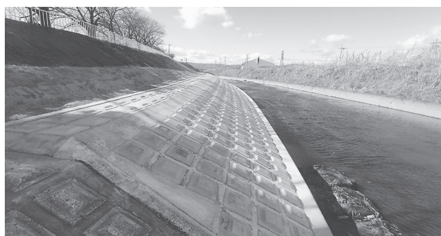
護岸整備が完了
