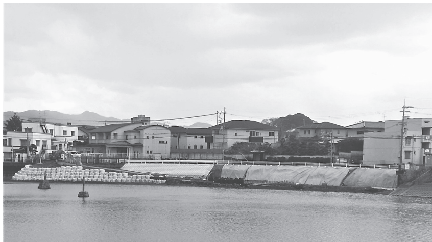
護岸を整備し路肩を保護する
