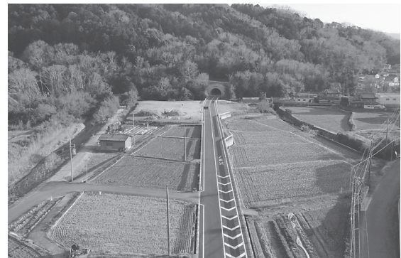
北側より栄山寺トンネル臨む
