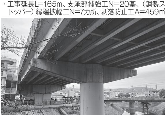
・工事延長L=165m、支承部補強工N=20基、(鋼製ストッパー)縁端拡幅工N=7力所、剥落防止工A=459㎡
