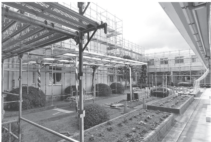
足場を組む作業が進む
