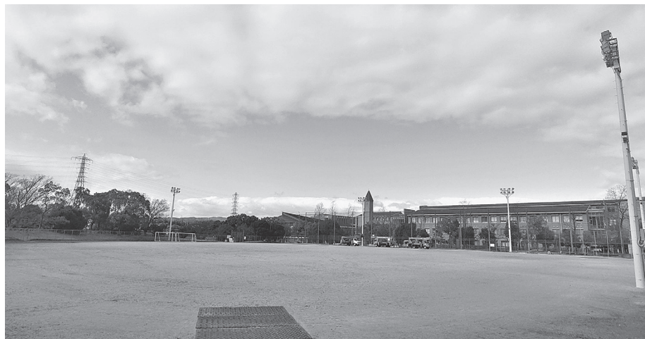
照明設備の取替工事が進む「高塚グラウンド」
