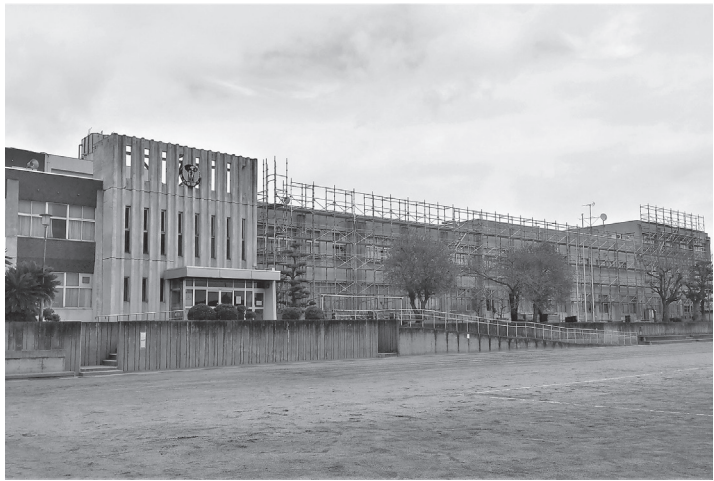
大規模改修に着手した「白鳳中学校南棟」
