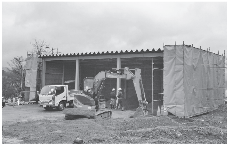
完成間近の車庫棟
