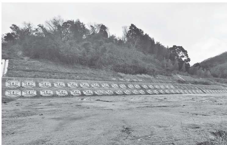
今期分の造成工事が完了
