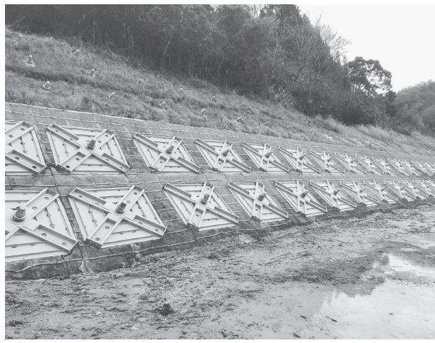
新たに52基のグランドアンカーを設置
