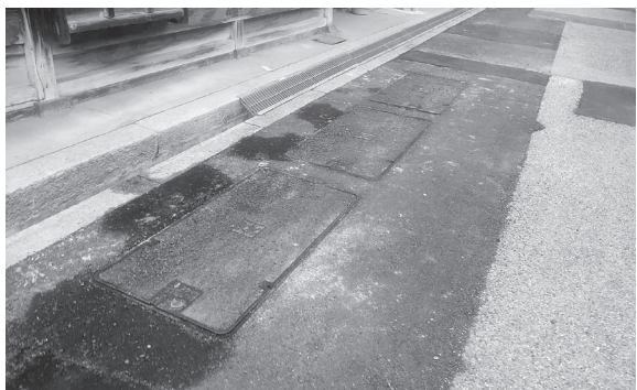
共同溝の工事は完了
