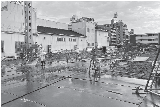
香芝市瓦口165号沿い(建設予定地)
