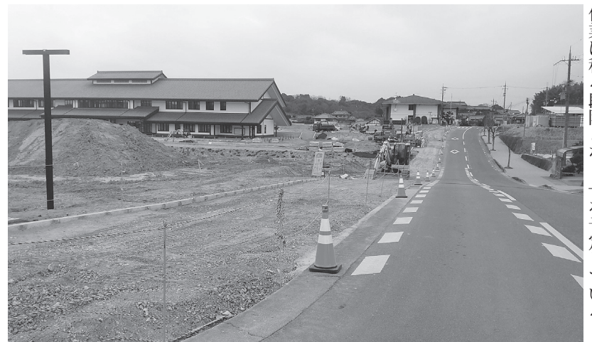
新庁舎の敷地に合わせて歩道の切下げを行う
