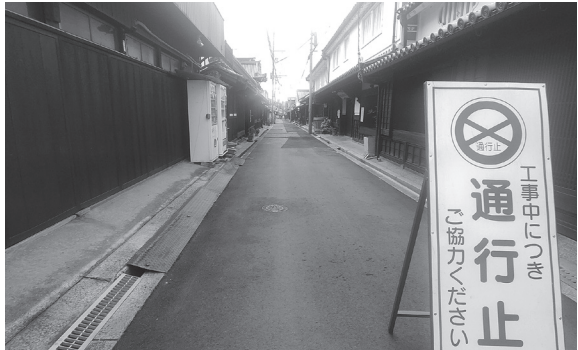
移設していたライフラインの復旧を行う
