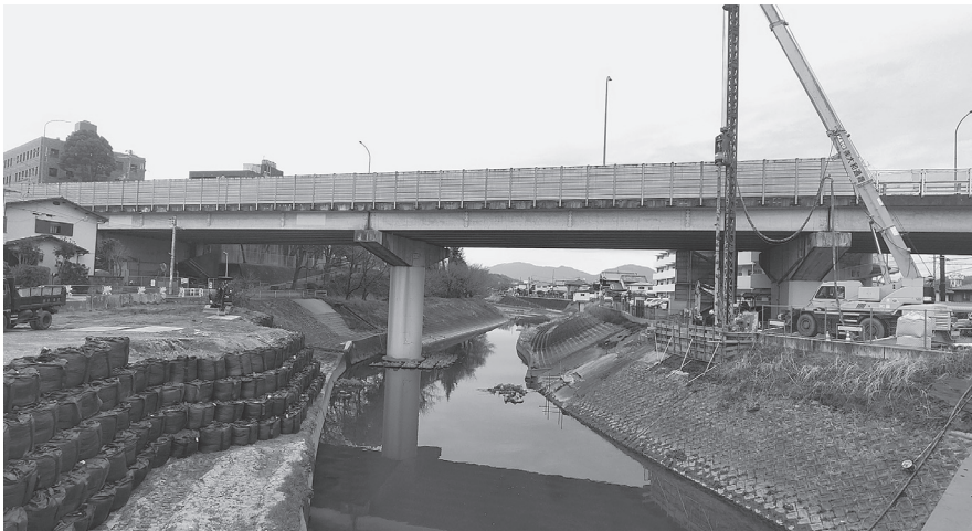
人道橋の下部工が進む
