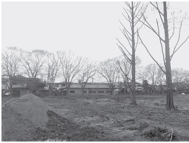
植栽などの撤去を行った
