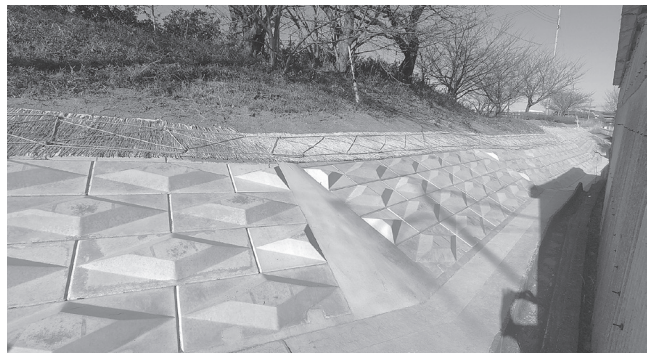
完成した連節ブロック張
