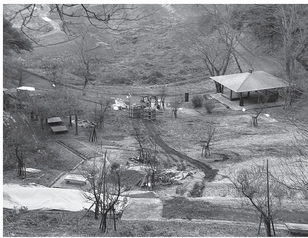
施工箇所の川原展望台北側の広場
