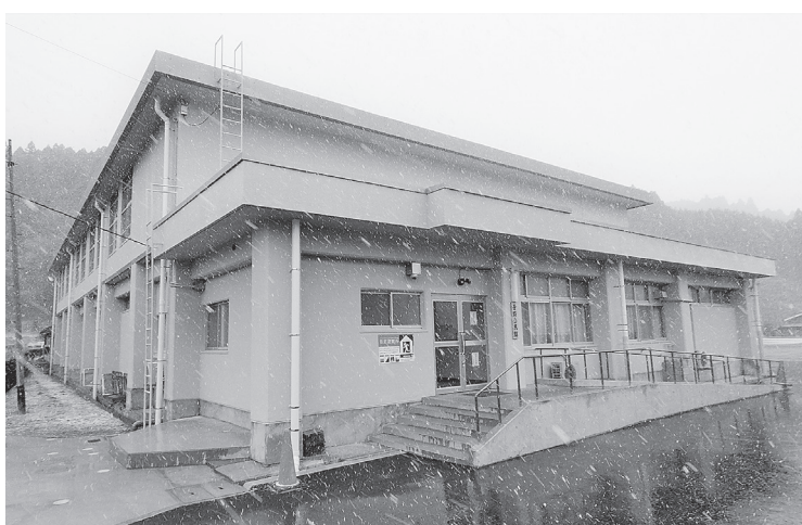
耐震改修工事を行った菅野公民館〔体育館〕
