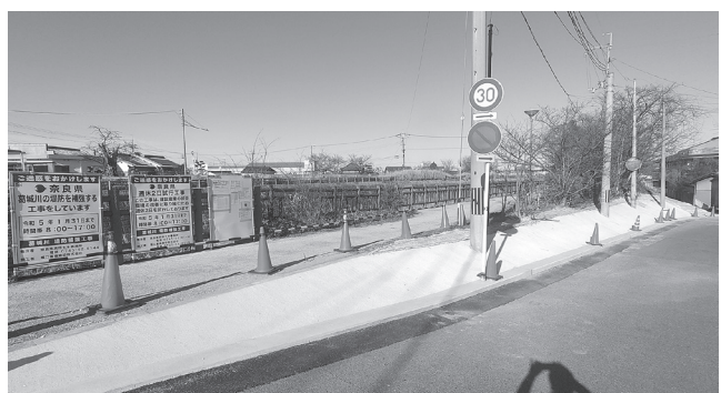
法面崩落を防止する工事
