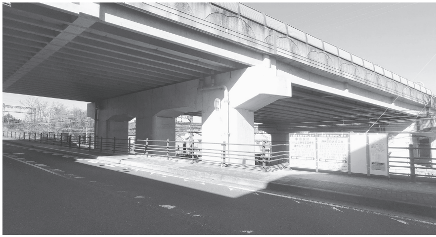
補修工事が行なわれた「中和幹線ツバ山近鉄線高架橋」
