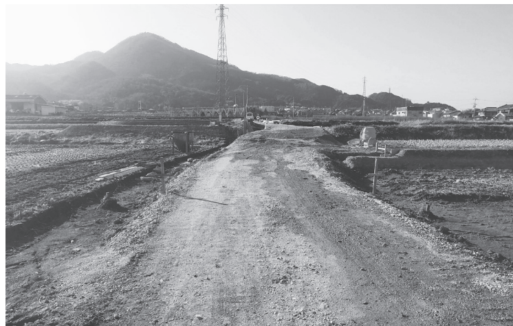
道路の建設が進む(磯壁7丁目)
