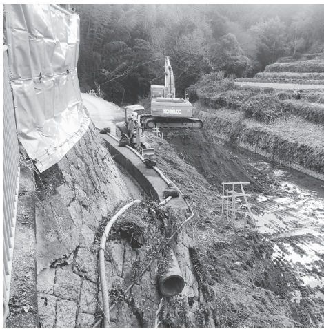
道路兼用の擁壁を整備する
