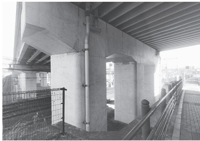
補修された橋脚
