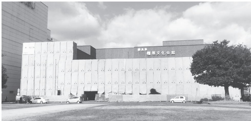
外壁改修工事が行われている「橿原文化会館」
