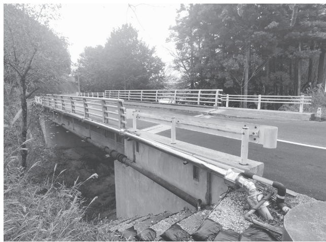
橋梁の長寿命化進む
