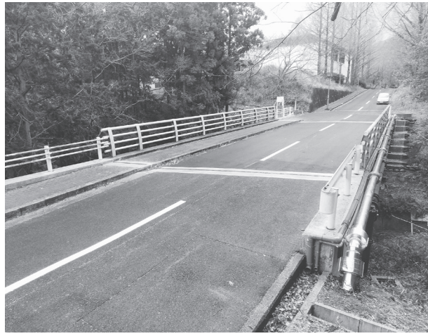
補修作業を終えた「中戸池橋」
