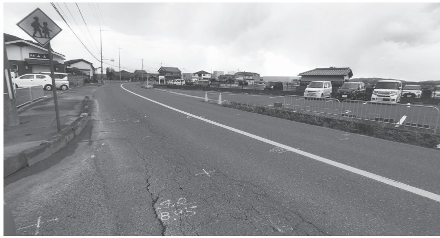
舗装補修工事を予定する天理王寺線 (唐院)
