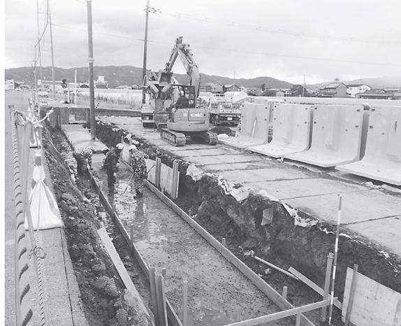
L型擁壁基礎部分の打設
