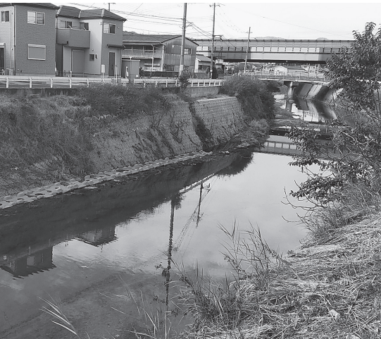
護岸工事予定地(香芝市上中)
