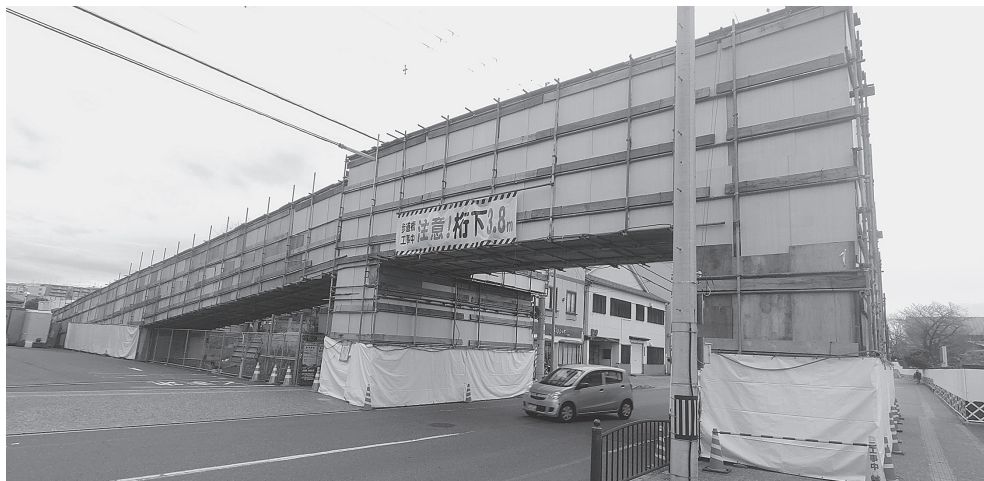
補修工事の始まった「柳町歩道橋」
