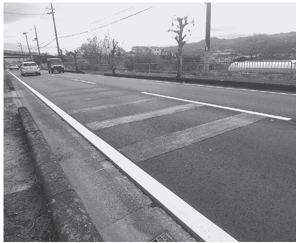
南向き車線の滑り止め舗装
