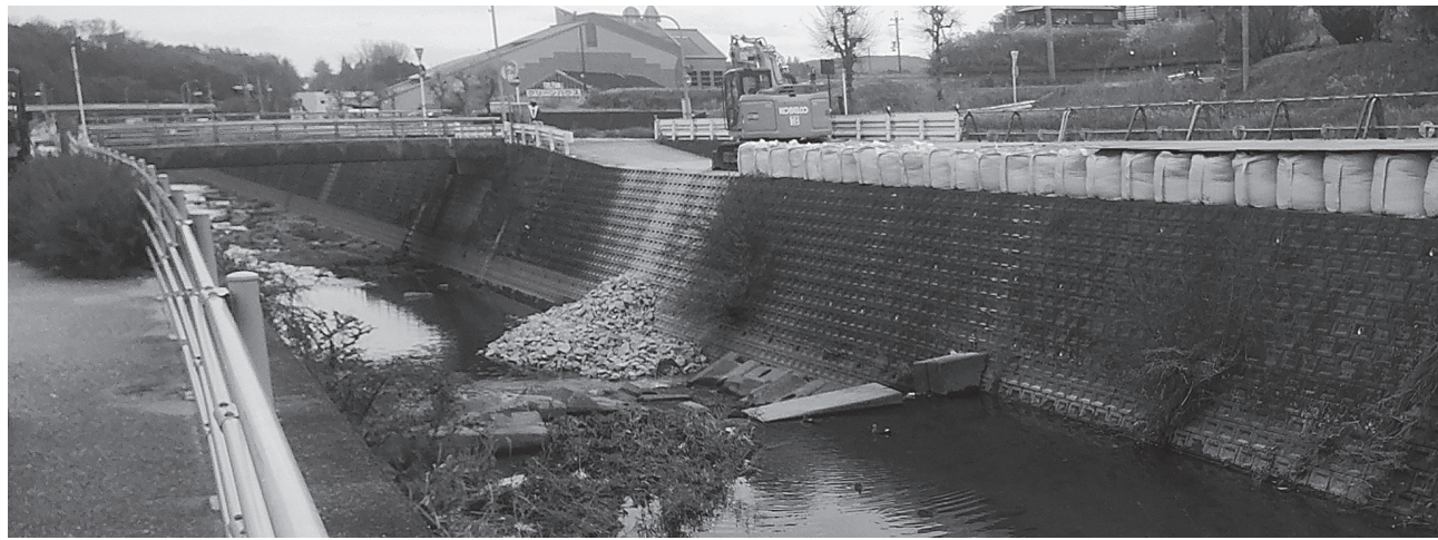
床止工事が行われている「富雄川」
