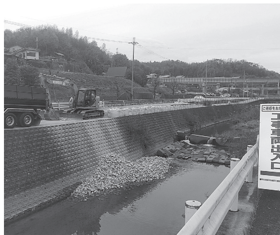
護岸基礎の保護も進める
