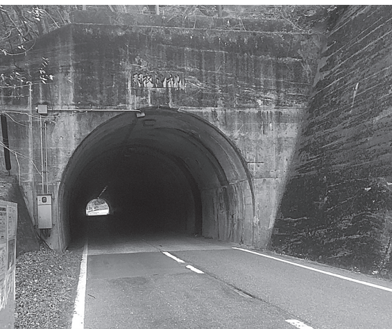
間もなく着工する「羽衣トンネル」
