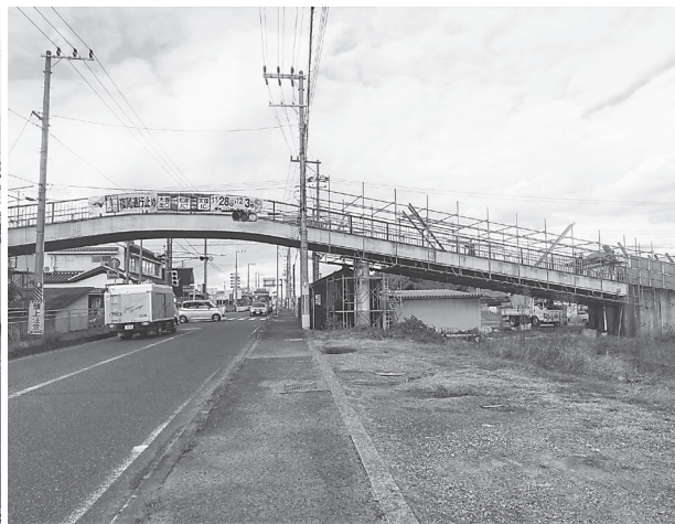
補修工事が始まった「穴闇歩道橋」
