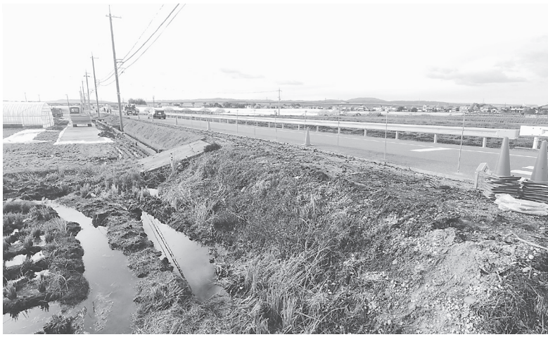
道路改良工事が行われている唐古西代線
