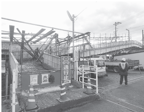
足場の組み立てが行われている
