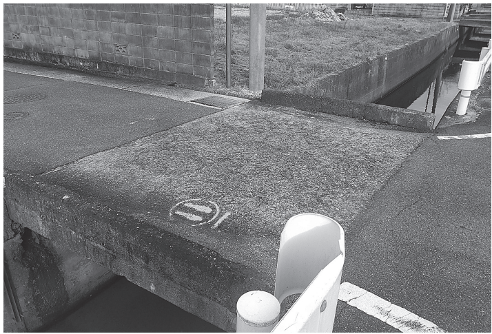
年内に施工完了予定の「黒田14号線1号橋」
