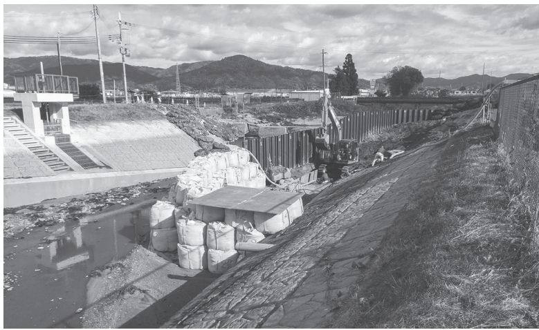
工事進む寺川(左岸)
