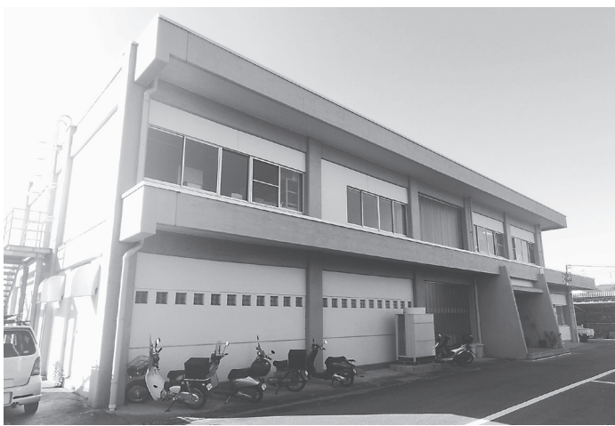
改修を行う水道事業管理棟
