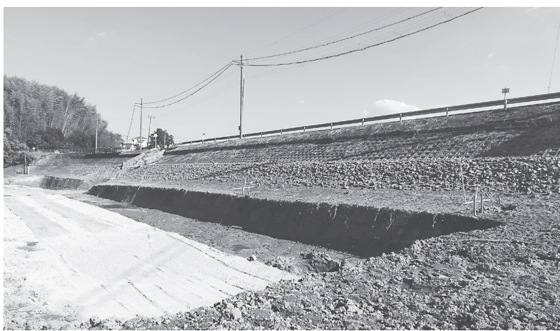
パワーブレンダー工法で地盤を改良
