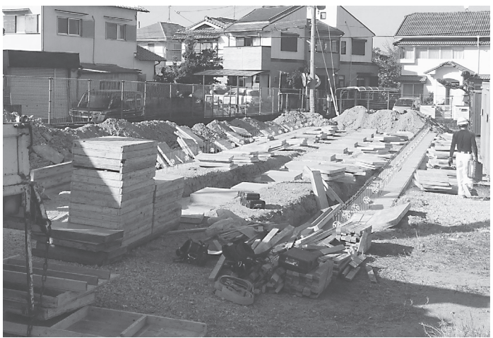
仮設事務所の工事が進んでいる
