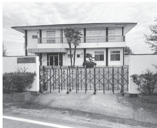
解体予定の農業研修センター(大字広瀬1239)
