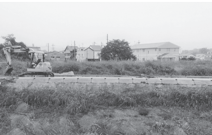
雨水の浸透を予防する工事
