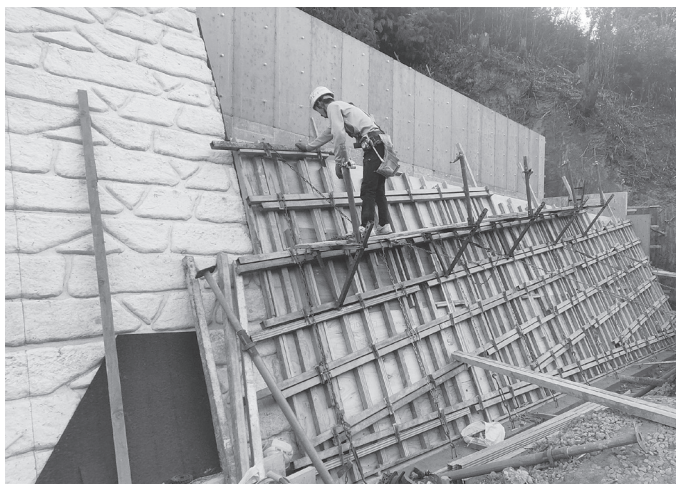
斜面对策工事が行われている
