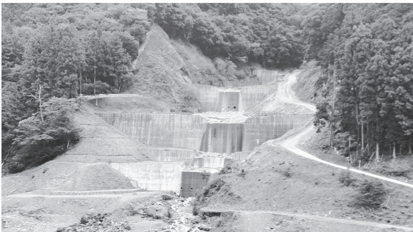
土砂の流出を防ぐ谷止工事
