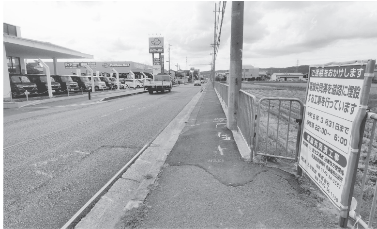
電線共同溝工事が行われる今国府町
