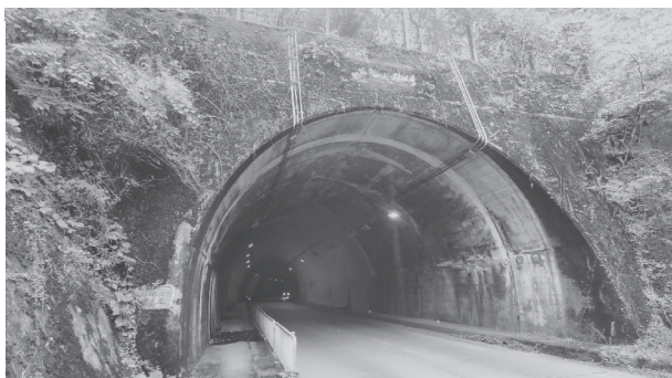
湯ノ原トンネル
