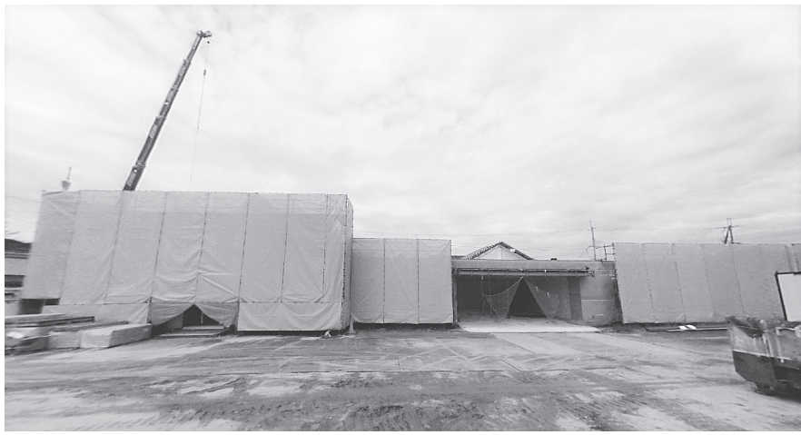
大規模改修が行われている「葛公民館」
