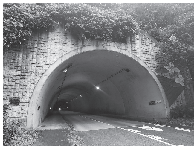
奈良名張線水間トンネル
