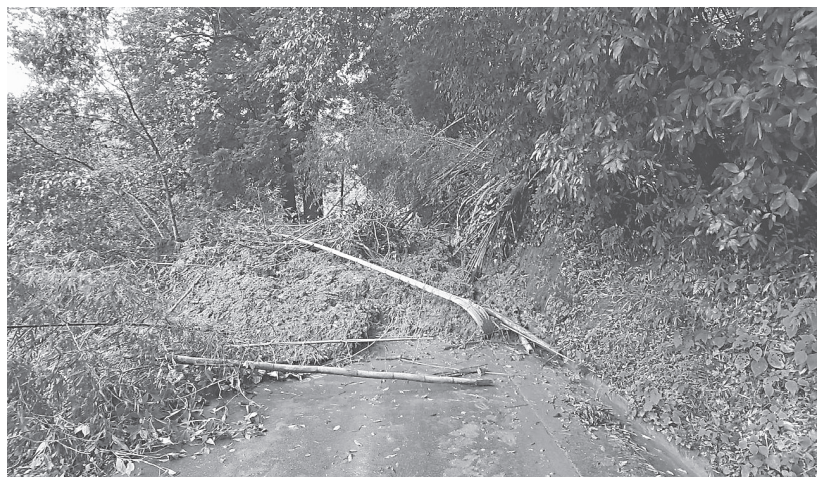
崩壊直後の現場(県提供/9月10日撮影)
