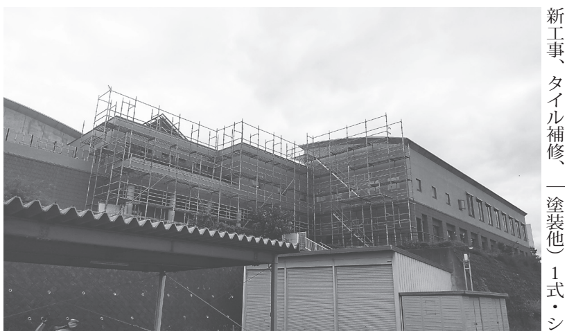
足場の解体が進む
