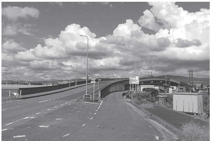
補修・補強工事が行われている「西新堂跨線橋」
