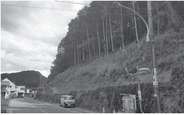
作業に着手した「橋屋工区」
