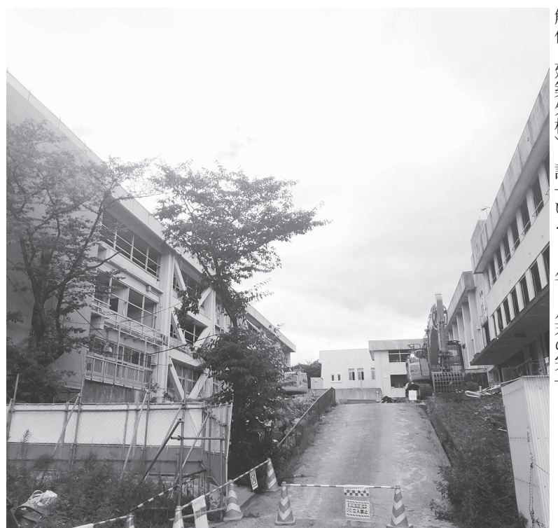
旧校舎の解体工事が進められている
