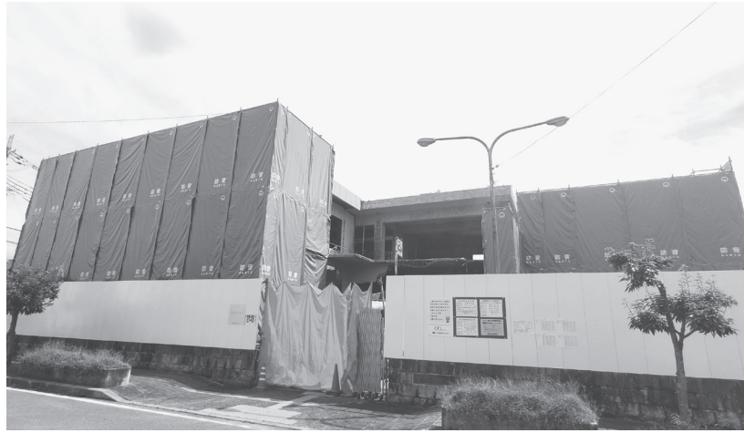
改修工事が行われている「大久保ふれあいセンター」
