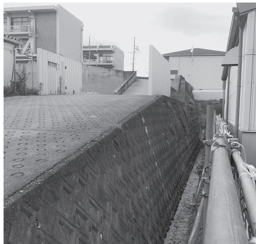
南東部の擁壁
