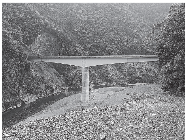
耐震補強が行われている「小休場橋」
