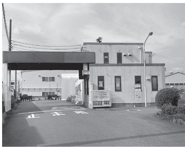
事務棟のみ残る衛生処理場(奥に分別ステーション)
