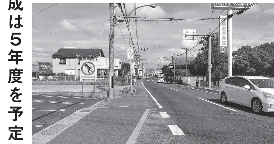
電線共同溝工事の準備が進む大和高田市神楽
