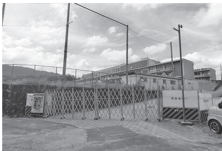
擁壁の改修が行われている新庄中学校
