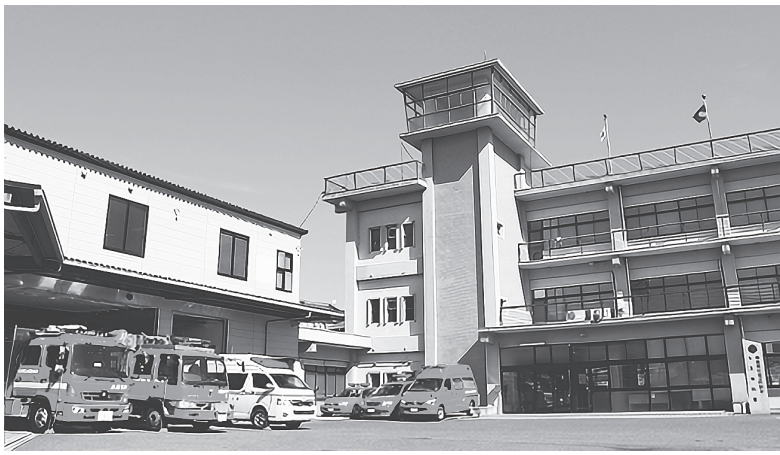
大淀消防署庁舎を建替える旧大淀役場庁舎(右)と現在、業務を行っている仮設庁舎(左)
