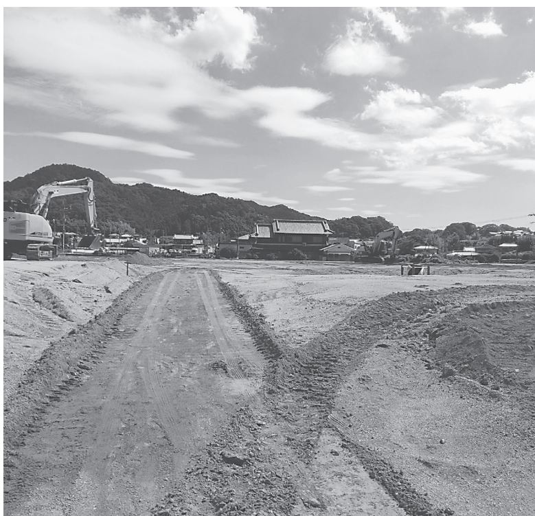
一次造成工事が進む建設予定地
