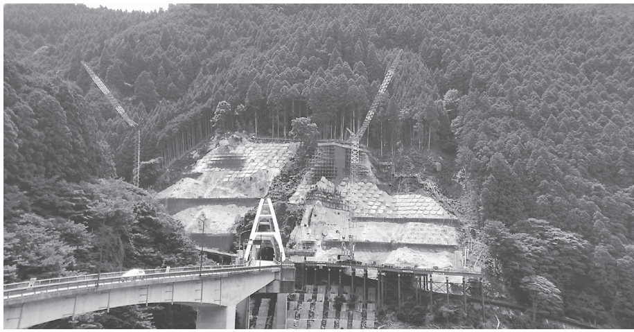
工事が行われている高原トンネル南坑口付近
