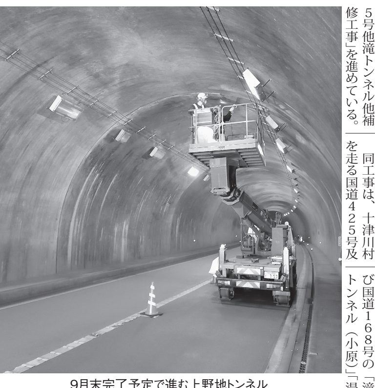
9月末完了予定で進む上野地トンネル
