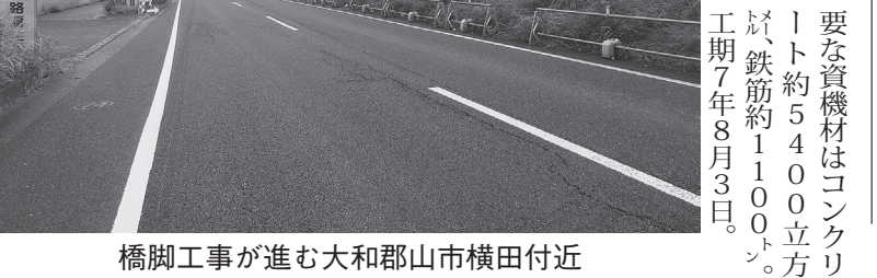
橋脚工事が進む大和郡山市横田付近
