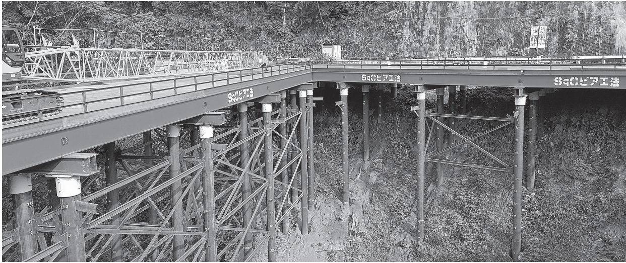
急峻な地形に栈橋を設置
