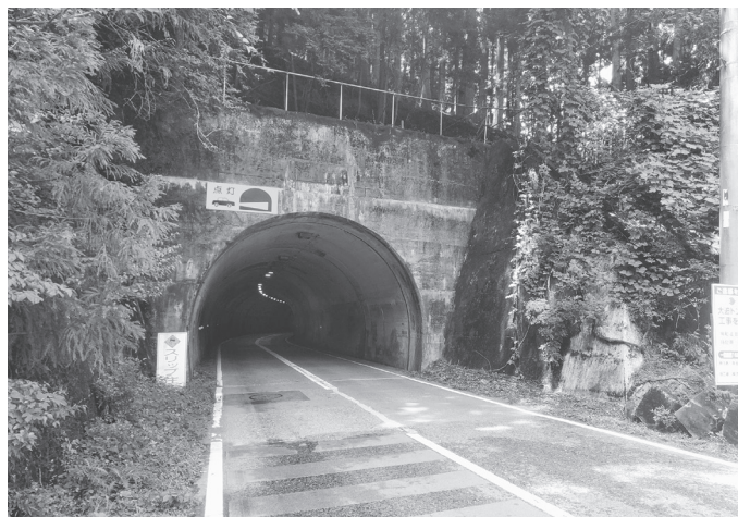
他工事と連携し工期を調整
