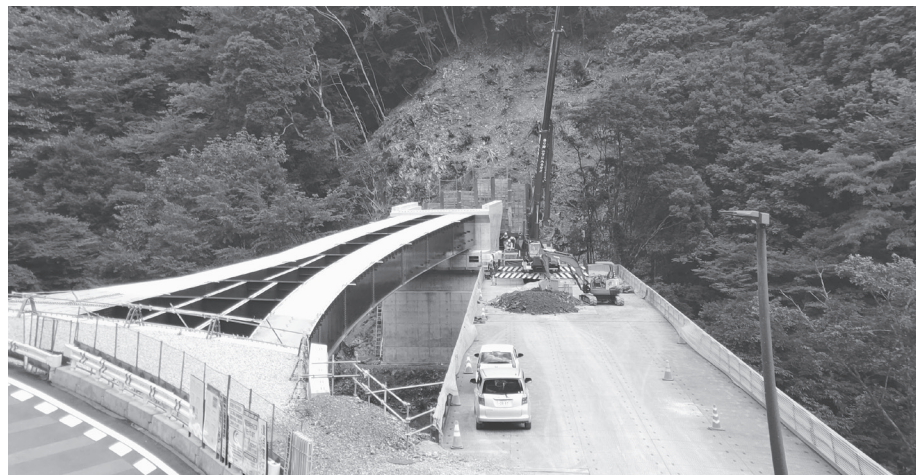
橋台の埋戻し作業を行う
