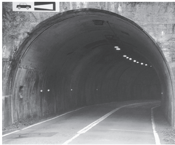
補修工事が行われる「大迫トンネル」
