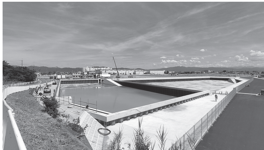
治水対策の大型調整池を整備
