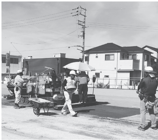
透水性のある土系舗装による施工
