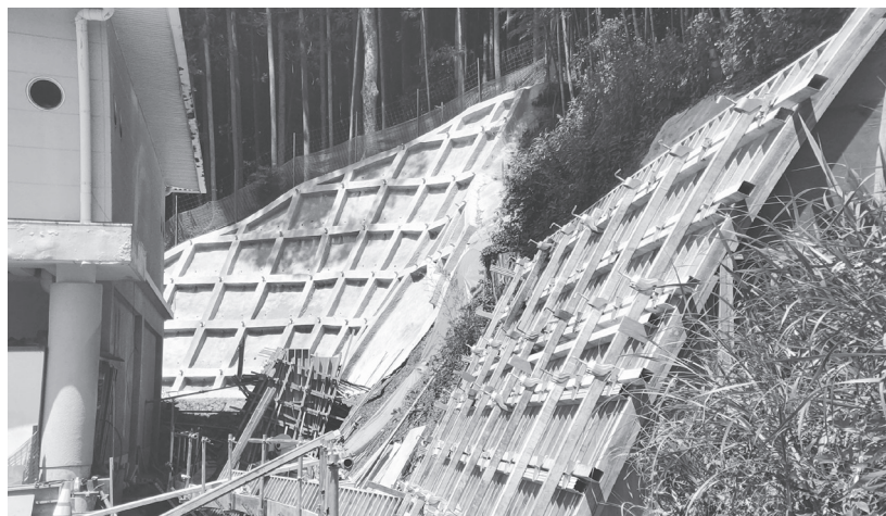
法枠工で整備進む
