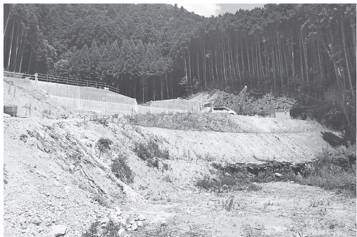
本堰堤の下流に副堰堤を築く
