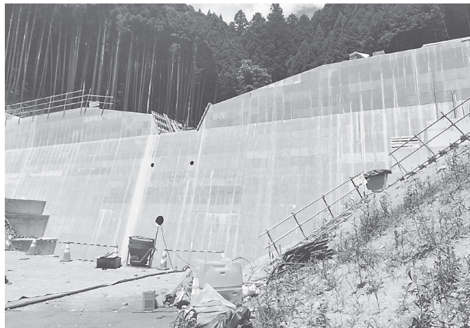
完成間近の本堰堤
