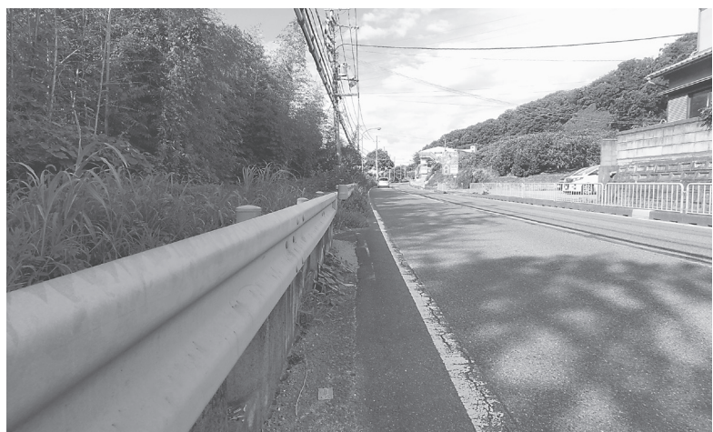
整備対象区間の藤井地区
