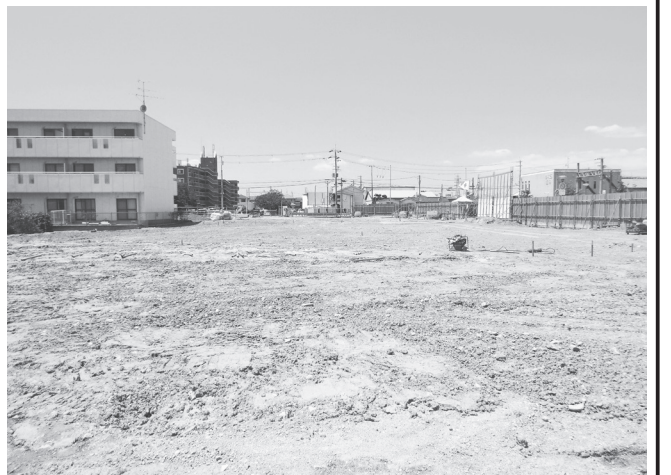
8月2日に起工式を予定する田原本駅南地区
