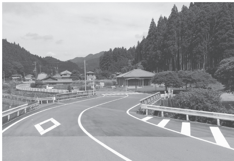
6月に完成した車谷橋
