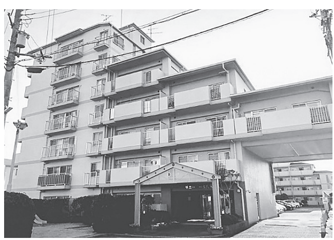
大規模修繕を行う「サニーコーポ八木西」
