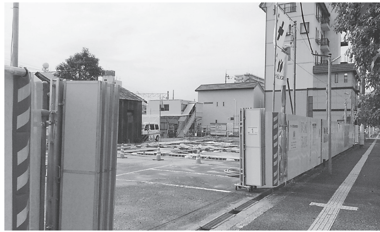
基礎打設を終えた現場の様子
