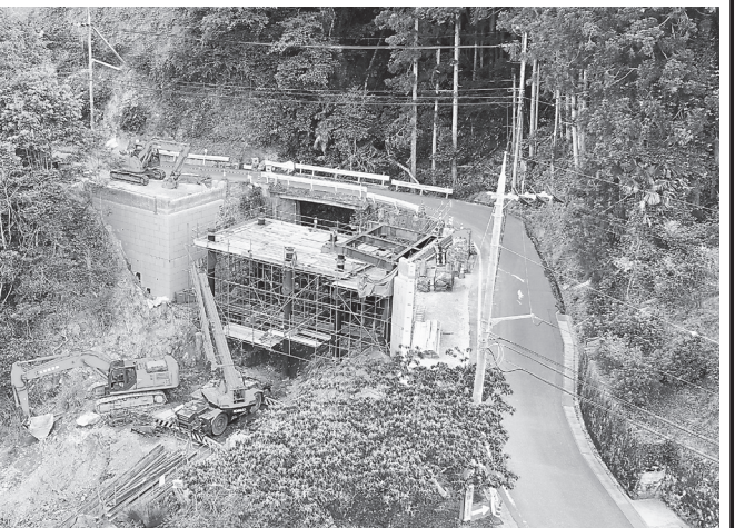
十津川村重里で進む拡幅工事(1.5車線化)
