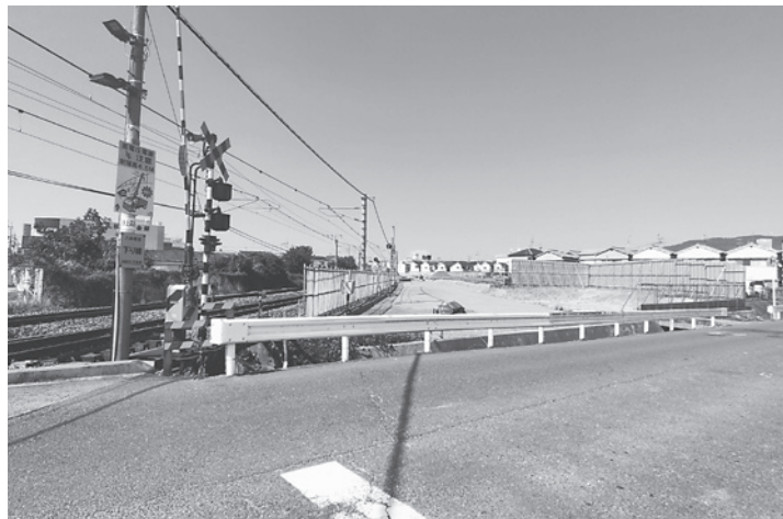
県とJR西日本は仮設線路の整備を進めている
