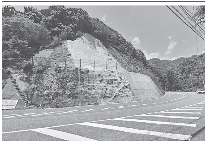
応急対策工事の吹付工は完了している
